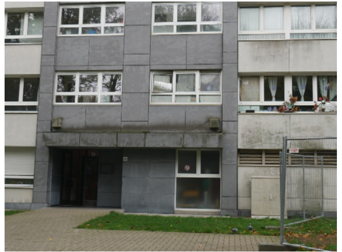
Au croisement entre les avenues Van Hoorenbeeck et Stevens, une tour peu accueillante.
